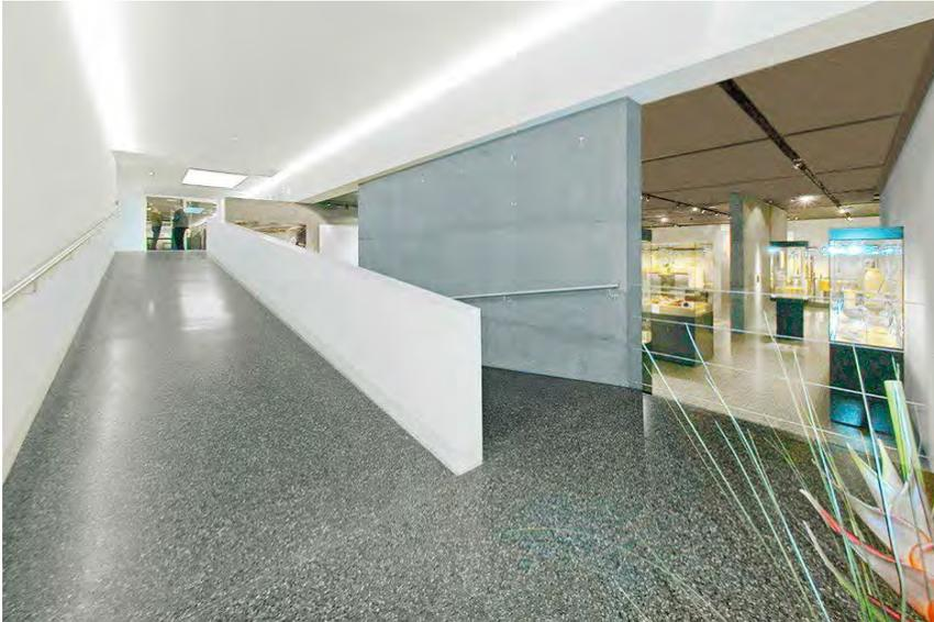
**Gussasphalt wurde bereits in der frühen Antike zur Abdichtung verwendet. Heute werden diese Beläge vermehrt auch im dekorativen Bereich eingesetzt.**
